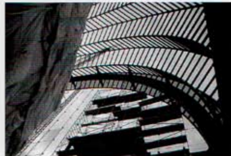
工事中の内部見上げ
