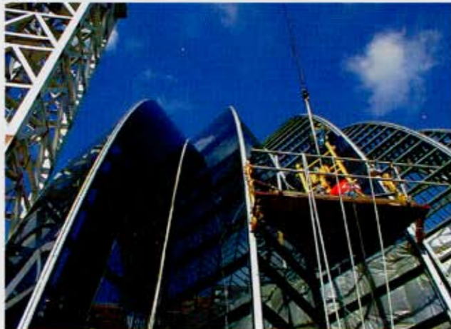
工事中のガラス屋根
