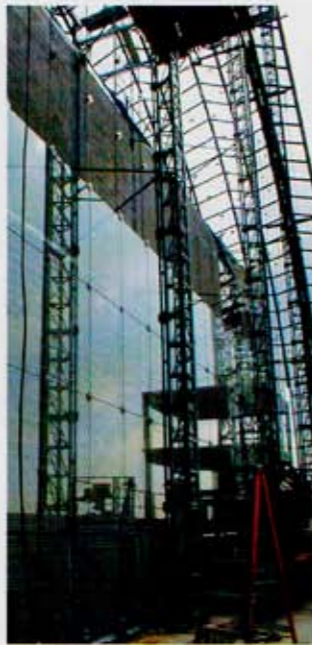
工事中のガラス壁面
